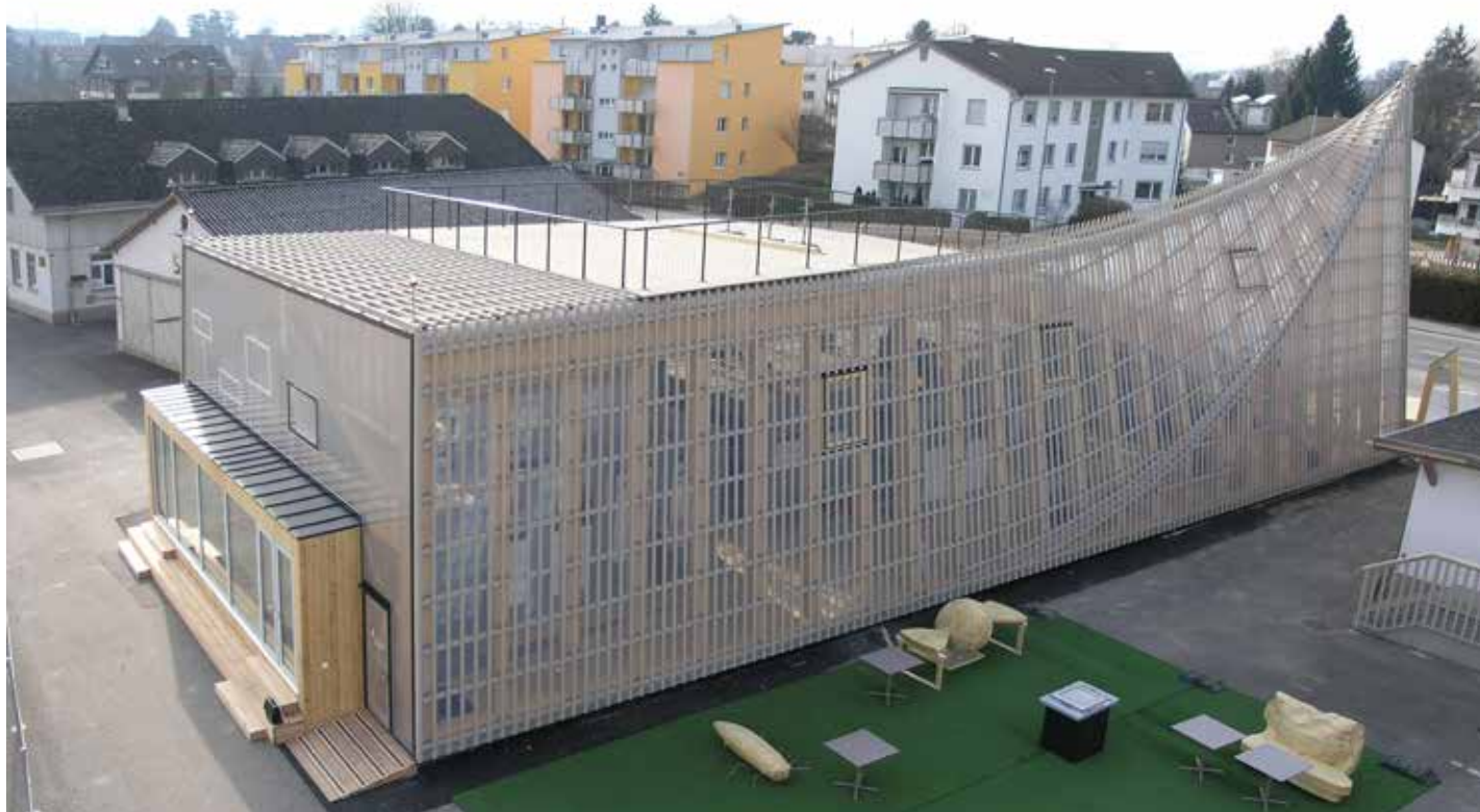
Pavillon Innovationspark Dübendorf mit Aussichtsplattform: Anlaufstelle und Treffpunkt für Wirtschaft, Investoren, Dienstleister und private Besucher (Bild: Blumer-Lehmann AG, Gossau).
