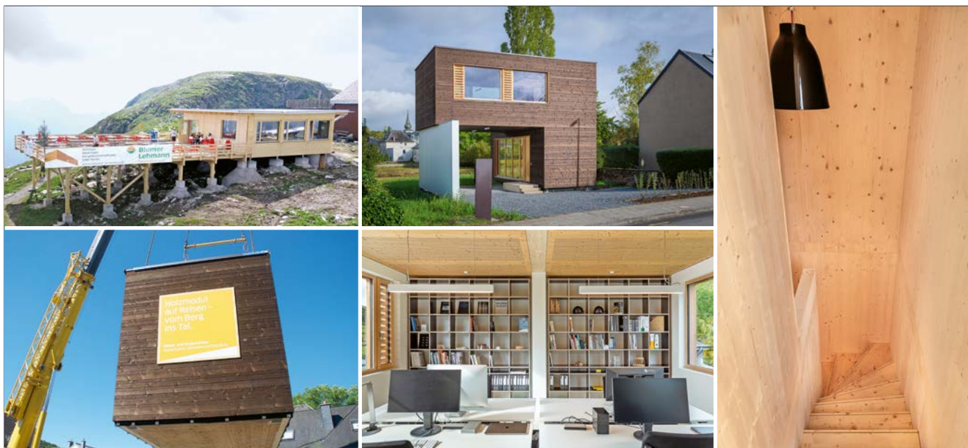
Von der Berghütte zum trendigen Architekturbüro: Modulbau aus Holz macht das möglich. (Fotos: Jan Marburg und zvg)
